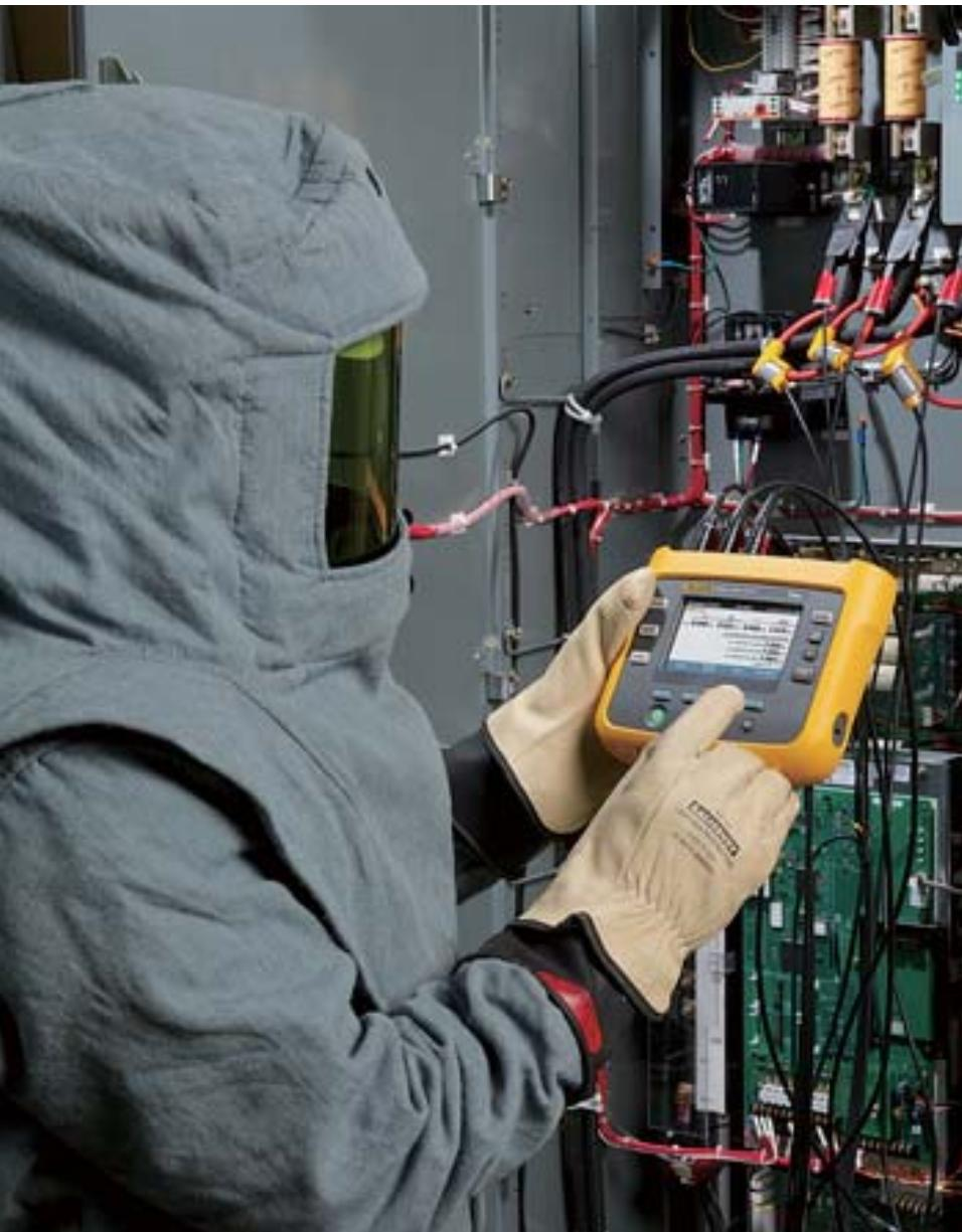
当地法规通常要求设备在为现有电气设备面板添加新负载前，先执行负载研究。电气工程师会在大规模扩大电气量时执行类似的研究。
