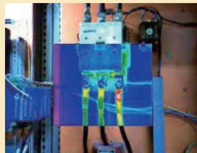
斷路器接線端接觸不良發熱
