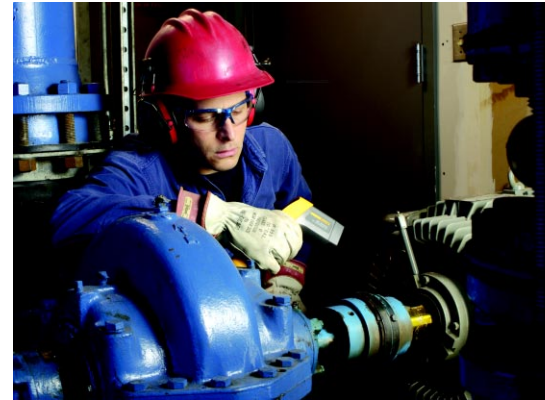
测量冷却泵电机轴承和机壳温度
