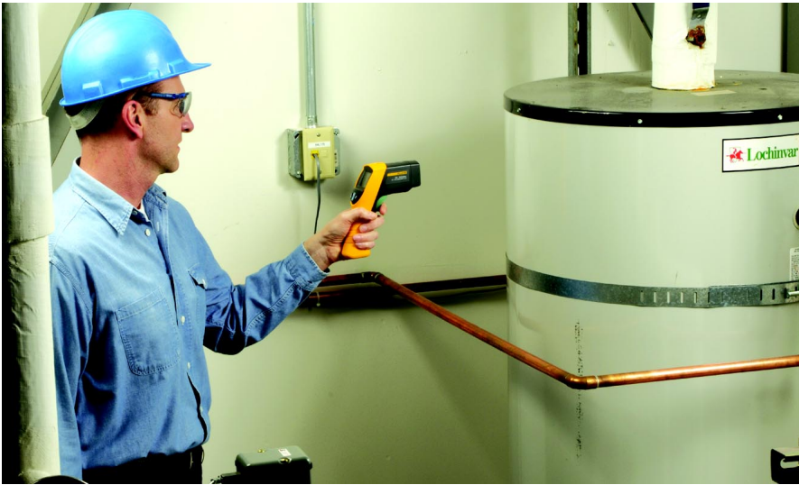
快速红外检测加热器和管道是否有有泄漏和温度不均衡情况。
